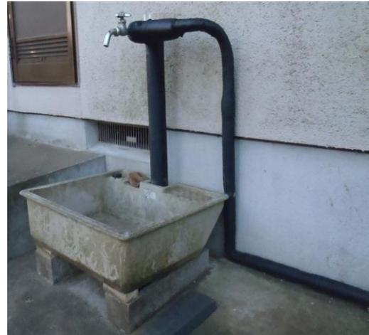
※むき出しの管に保温材使用の例
